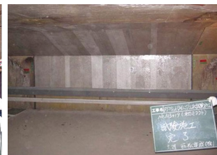
写真-5 施工完了状況
