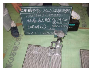
写真-6 付着強度試験
