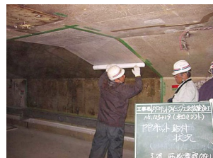
写真-4 シート貼付作業
