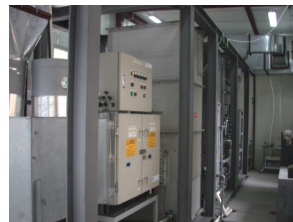
写真-3 装置設置状況
