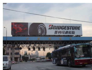
写真-1 トンネル入口
