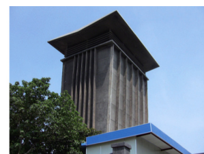
写真-2 換気所外観
