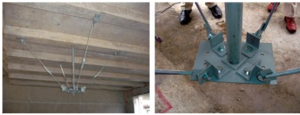
写真一 1 ポストタイプ制震天井の設置状況
