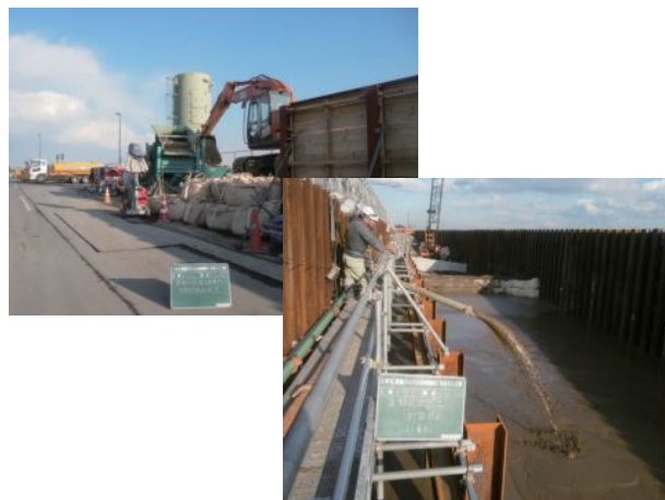
写真—7 流動化処理土プラントと打設状況
