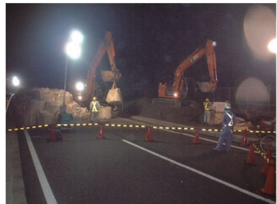
写真一3 大型土のう製作状況
