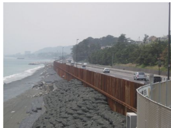
写真—8 暫定4車線供用状況
