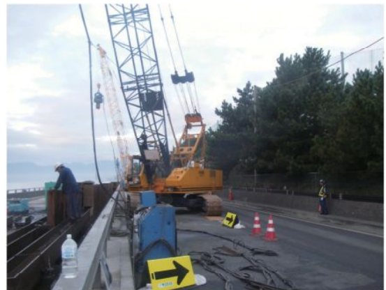
写真一2 上り線2車線利用の施工スペース
