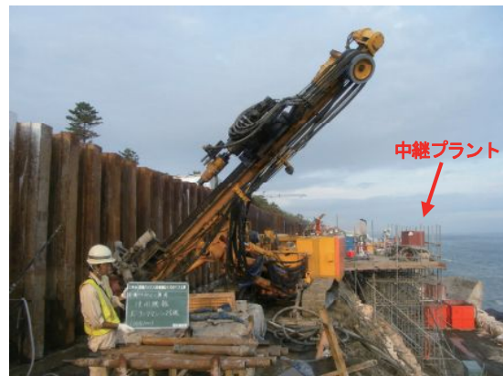
写真—5 アンカー施工状況
