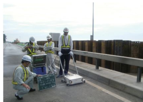
写真一4 路面下空洞調査状況
