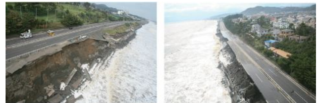
写真一 西湘バイパス被災状況 (横浜国道事務所より)
