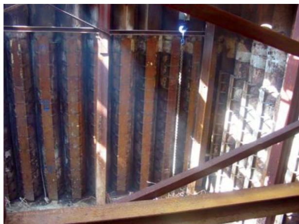
写真一2 鋼管矢板補強状況
