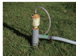
写真－2 EDC注入状況
