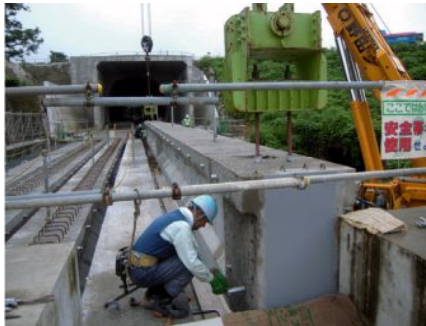
写真一3 機械式継手採用による施工 (Ctp8)
