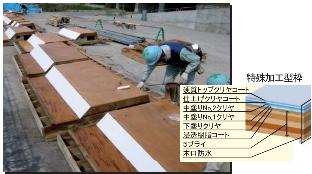
写真一2 表面特殊加工型枠, 打継目処理剤塗布
