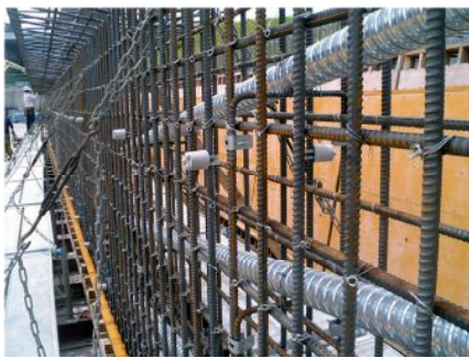
写真一4 シース管配置、配筋状況
