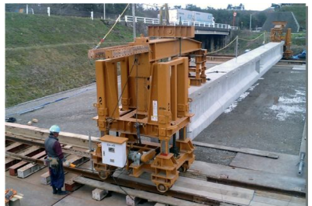
写真-1 電動PC桁横取装置による施工
