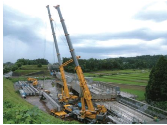
写真-5 Ctp8 主桁の架設状況
