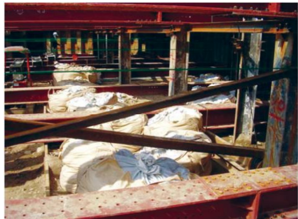
写真一3 大型土嚢載荷状況写真
