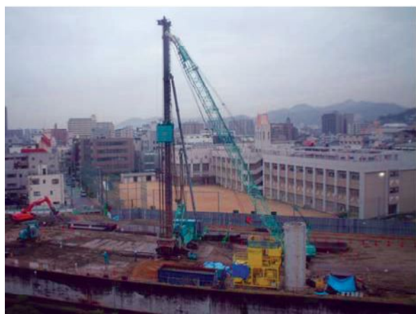
写真-1 ECW工法施工全景写真
