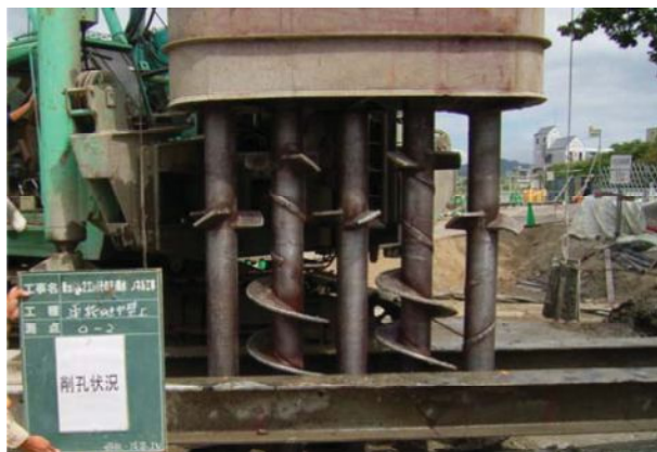
写真-2 ECW工法先端部写真
