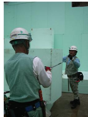
写真一 2 EPS 材の切断状況
