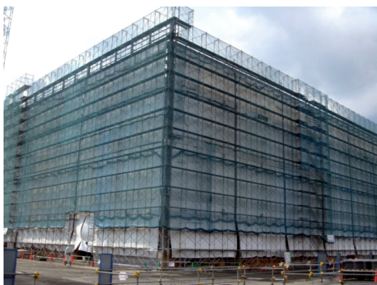
写真一2 建物外周部における遮風状況
