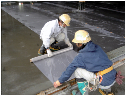
写真-3 PEフィルムの敷込み状況
