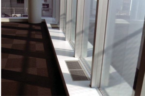
写真一二 定風量換気装置施工例
