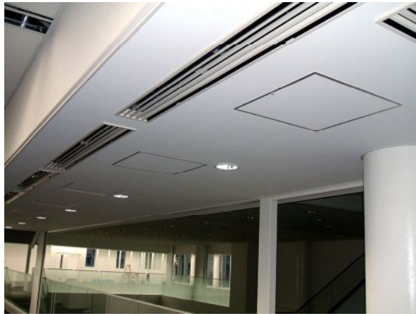
写真一三 吹抜部エアーカーテン施工例
