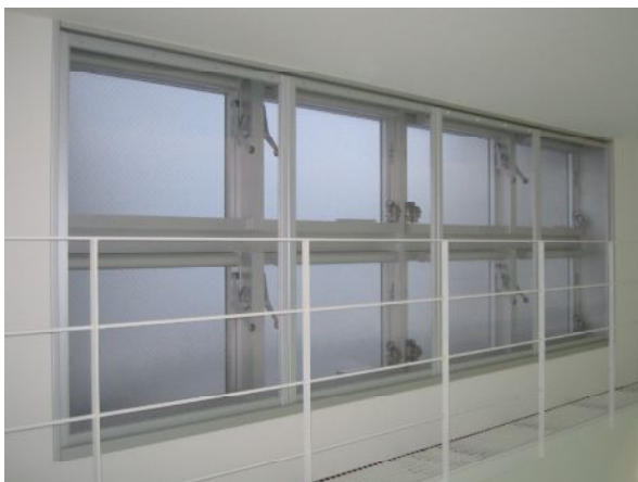
写真一四 バランス型排気窓施工例
