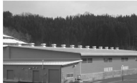
写真一5 換気ファン設置状況
