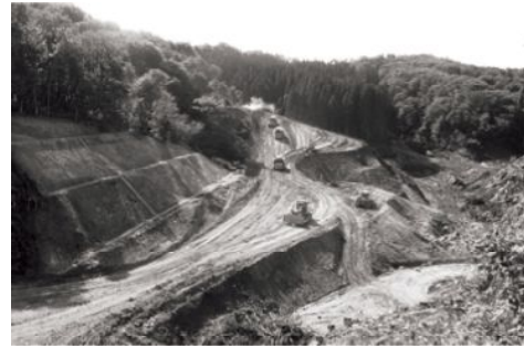
写真一2 造成工事施工状況
