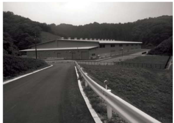
写真一 完成写真
