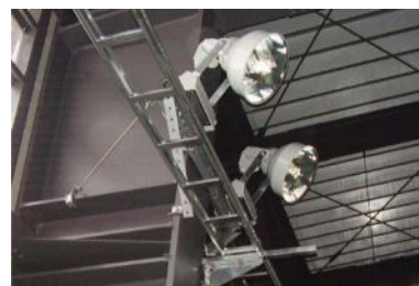
写真一6 照明器具取付状況
