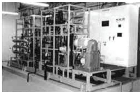
写真一4 逆浸透膜装置
