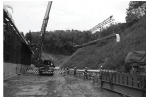
写真-3 屋根材現場成型状況
