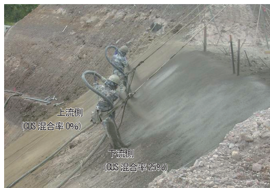
写真-2 堤体左岸部仮設法面での吹付け状況
