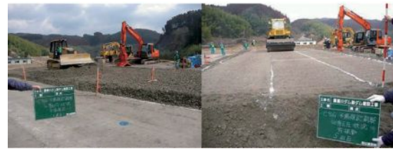
写真一2 敷均し状況と転圧状況
