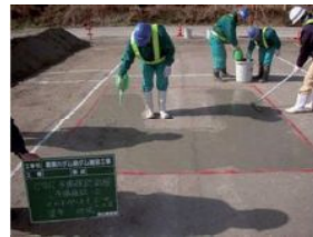
写真一4 セメントペースト塗布状況
