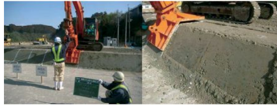
写真一3 法肩締固め機械と締固め状況
