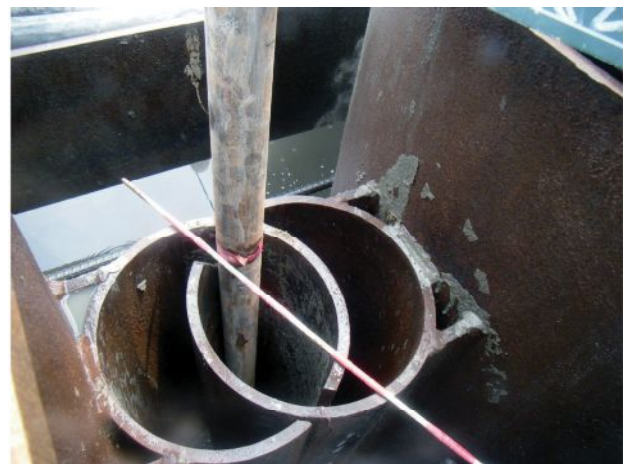
写真二2 継手管内洗浄状況
