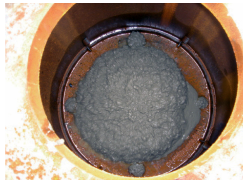
写真一1 打設状況
