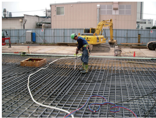
写真一 打ち継ぎ面の処理状況
