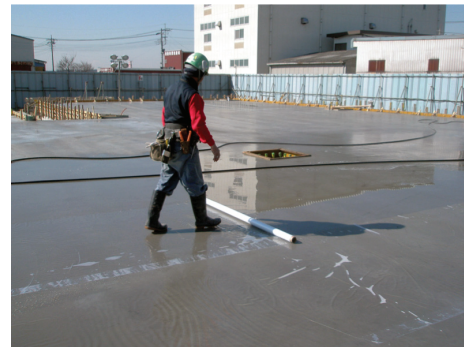
写真二 散水シート養生施工状況
