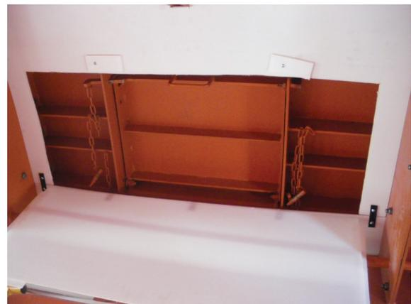
写真—7 側フォーム部（打設窓箇所）
