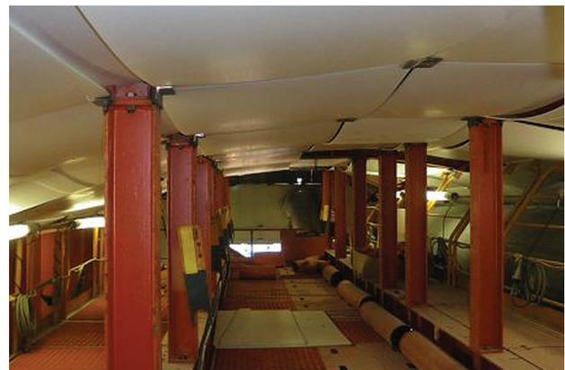
写真-3 温ぬく養生状況 (例: セントル天端部)
