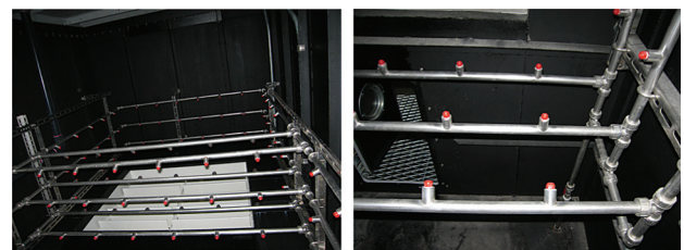
写真-1 噴霧ノズル設置状況 (左：装置下方からの写真 右：ノズル拡大写真)
