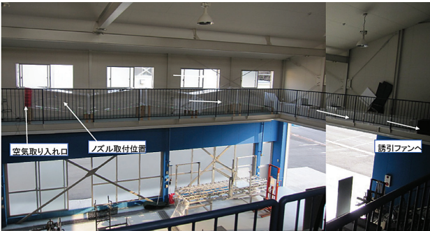
写真－2 風洞実験設備外観
