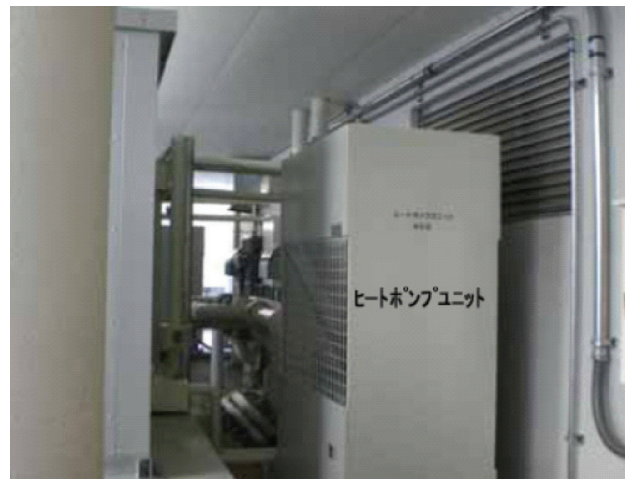
写真一 ヒートポンプユニットの設置状況
