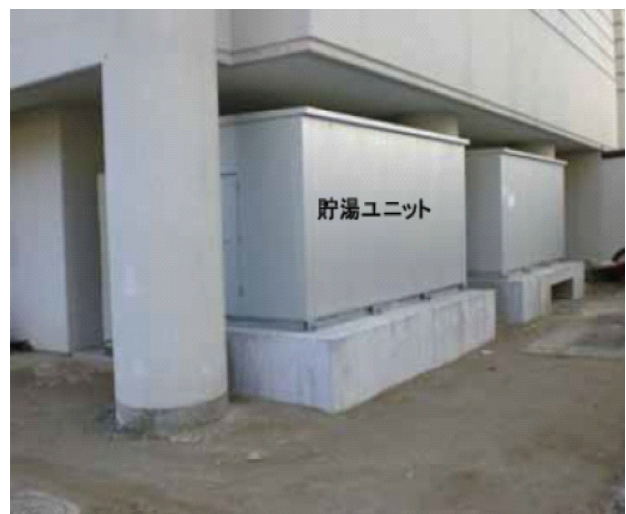
写真二 貯湯タンクユニットの設置状況
