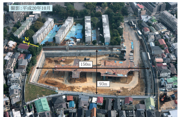
写真一 工事現場全景
