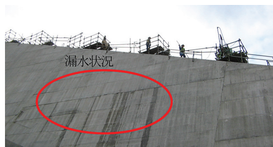
写真一八 加圧注入によるクラックの貫通確認状況
