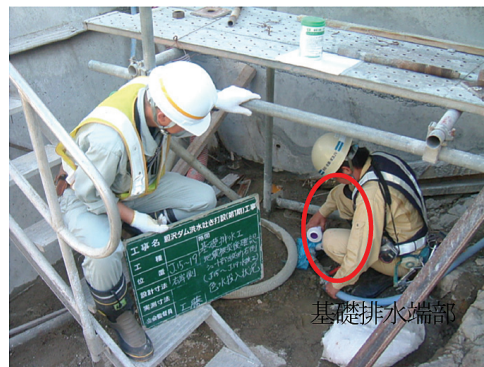
写真-11 基礎排水調査状況(着色水による通水試験)
