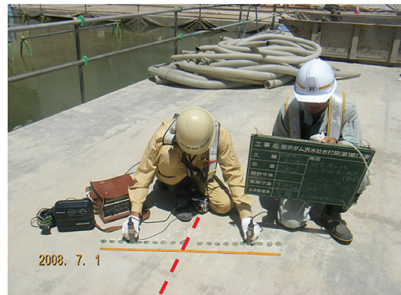
写真-4 超音波法（2 探触子法）によるクラック深さ測定状況
