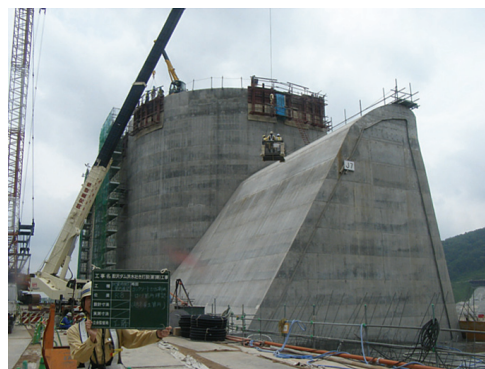
写真一2 ゴンドラを用いた高所観察状況
