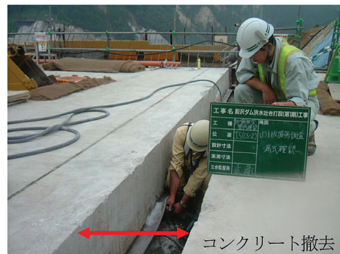
写真一六 止水板調査状況
