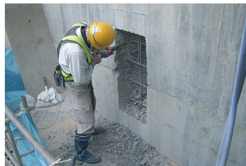
写真-12 鉄筋試料採取状況
