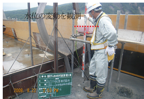
写真一七 加圧注入による止水板調査状況
