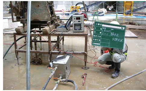
写真-10 透水試験状況
