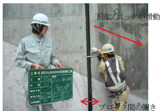
写真一3 ブロック間の開き測定状況
