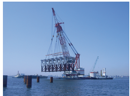
写真-2 ジャケット据付
