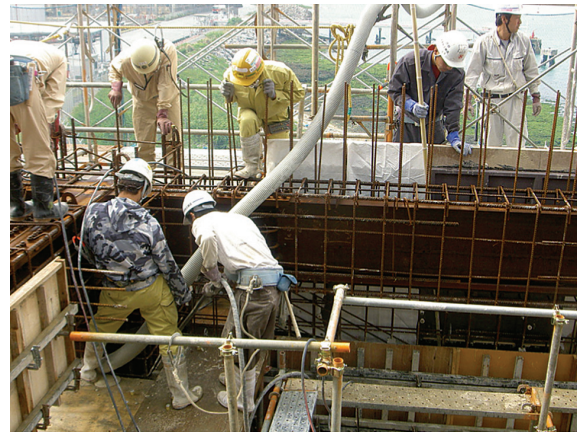
写真—7 筒先部分のゴム型枠面シート養生状況
