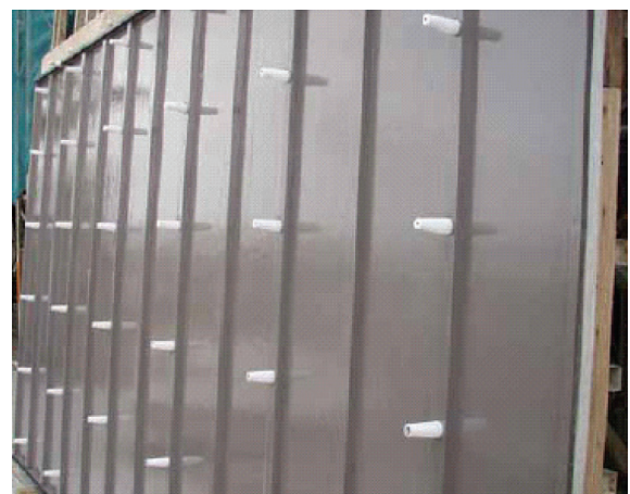
写真—4 シリコンコーティングしたゴム型枠
