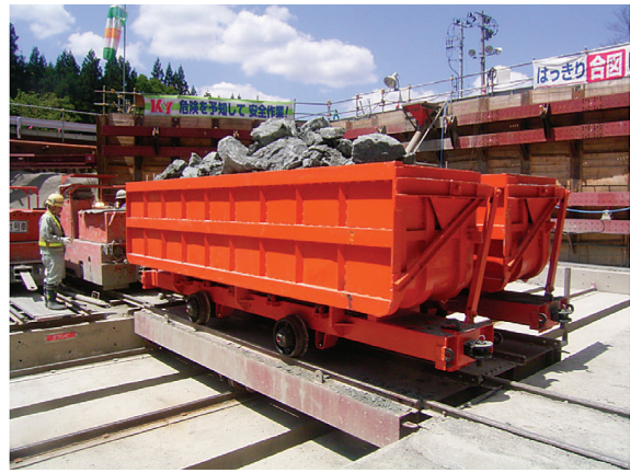
写真一 3 トラバーサへの施工機械配置状況 (2台配置状況)
