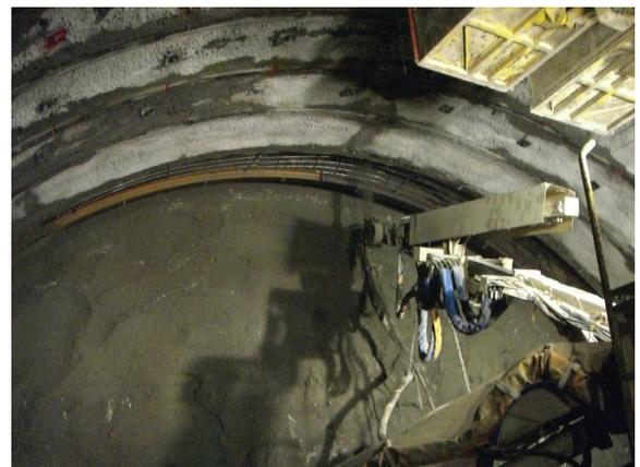
写真-2 エアレス吹付システムによる吹付状況
