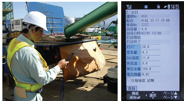
写真-1 現場適用状況
