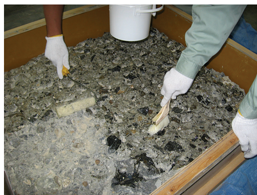
写真一 樹脂製接着剤の塗布状況
