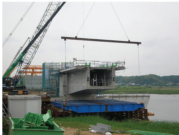
写真-1 鈹桁撤去状況
