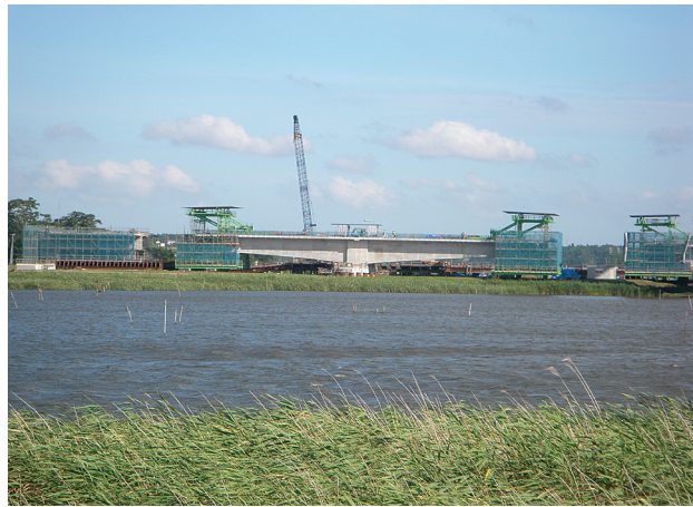
写真-2 張出し施工状況
