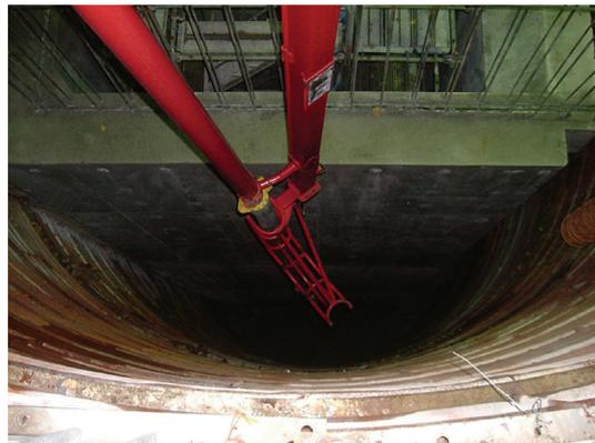
写真一4 コンクリートポンプによる圧送
