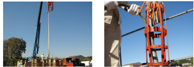
写真-1 打設状況及び棒状バイブレータ固定用治具
