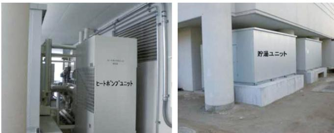
図-2 ヒートポンプユニットと貯湯ユニットの設置状況
