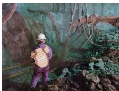
写真-2 吹付け状況
