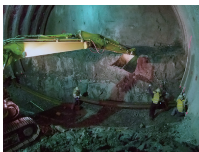
写真-1 ストラット設置状況
