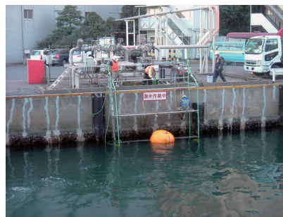
写真-2 クラック補修（笠コン）
