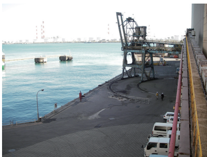
写真-1 矢板式岸壁
