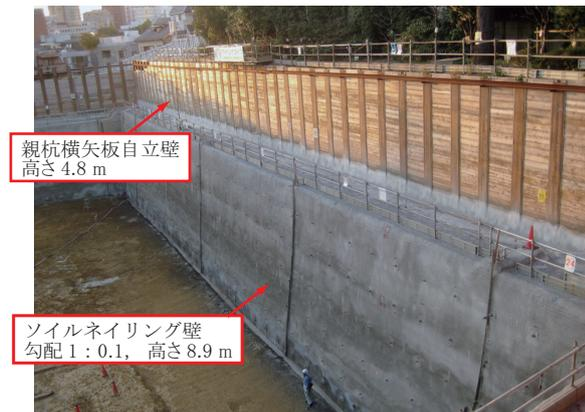
写真-2 床付け完了状況
