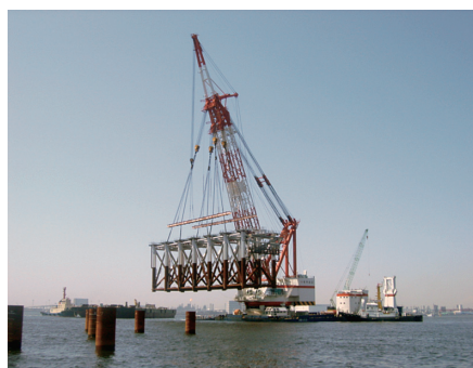
写真－3 ジャケット据え付け
