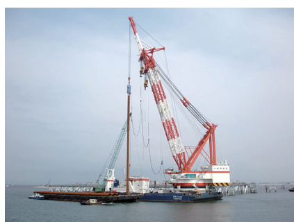
写真－2 鋼管杭打設
