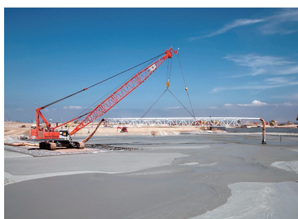
写真－4 軽量混合処理土打設
