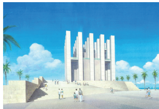
三重城側換気塔外観（上：完成写真，下：パース図）
