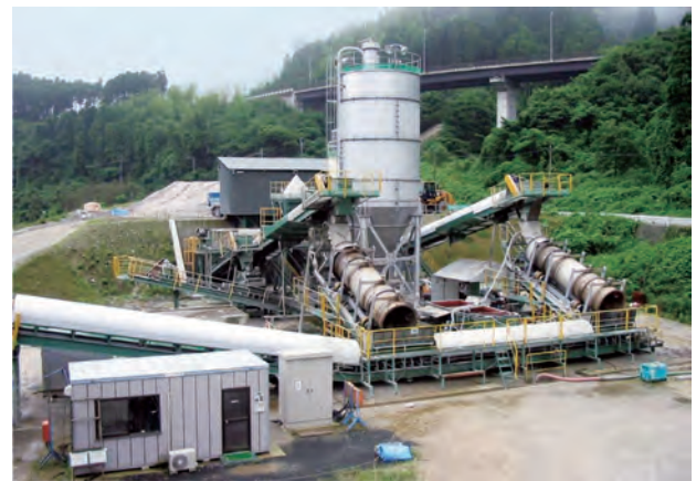
写真一1 CRT ミキサシステムの全景
