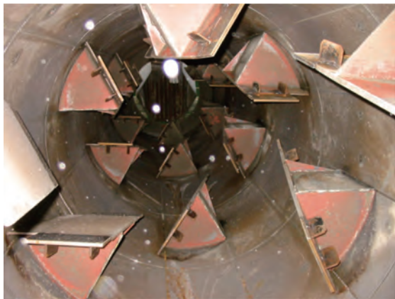
写真一13 改造後の状況
