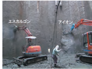
写真一六 壁面整形状況
