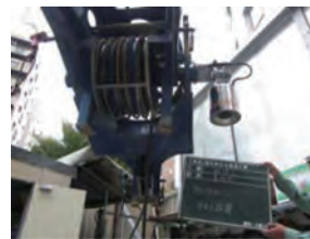
写真一八 モニター設置
