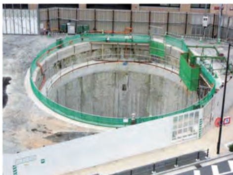
写真一1 頭部連結状況
