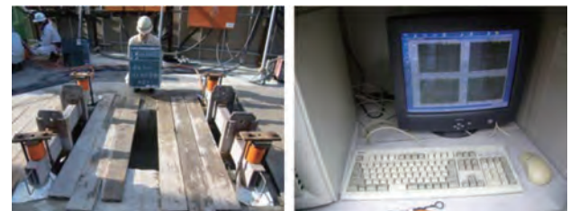
写真-4 浮上がり力・沈下力測定状況
