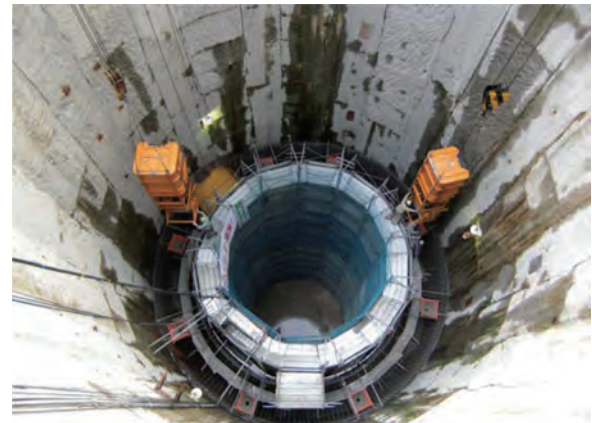
写真一七 朝顔ホッパーと打設状況
