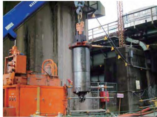
写真-3 N-BH 掘削機据付
