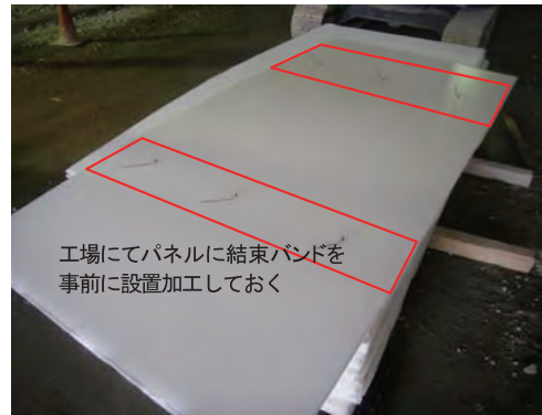
写真-5 結束バンド設置状況
