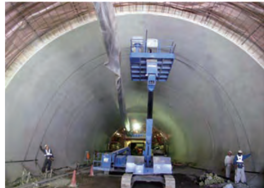
写真-6 骨組み組立状況
