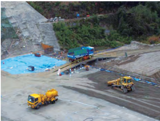
写真一三 乗込み架台
