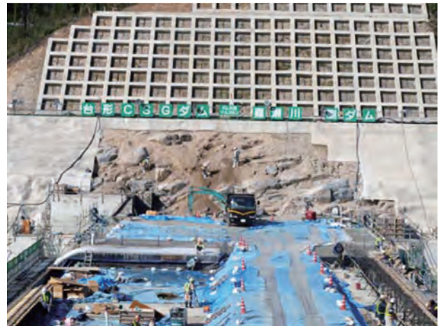
写真一五 CSG部の岩盤仕上げ掘削
