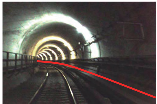
— 連結2次元変位計設置位置
