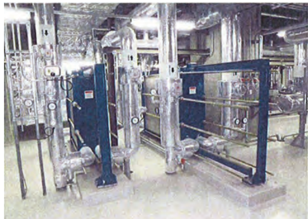
写真一3 プレート熱交換器
