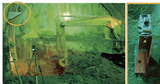
写真-1 試験施工 (TS 設置) 状況
