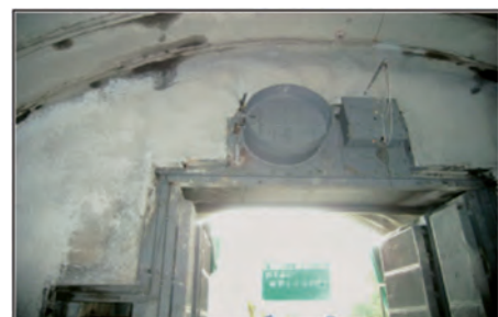
写真一 No.1防音扉（改良後）
