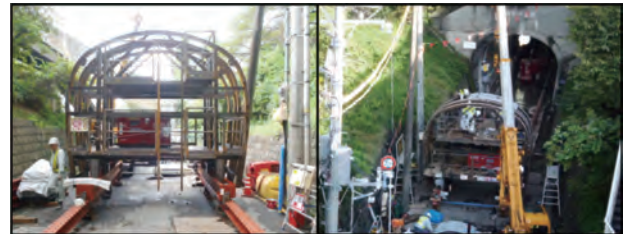
写真一3 本工事で採用した鋼板補強工の施工方法
