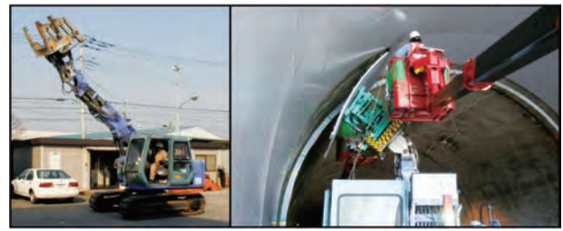
写真一2 一般的な鋼板補強工の施工方法
