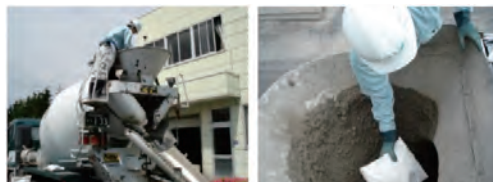
写真二 繊維投入状況
