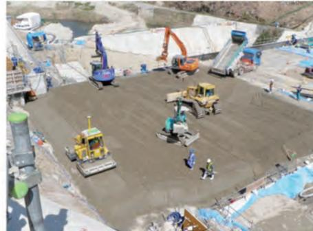
写真-4 CSG 打設状況全景
