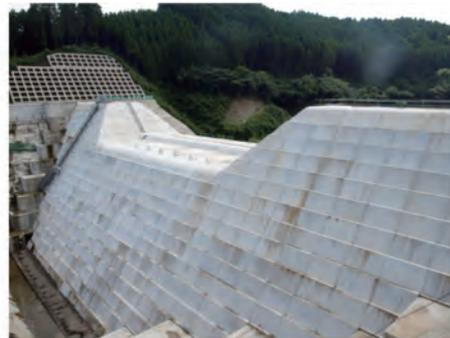
写真-2 プレキャスト型枠全景
