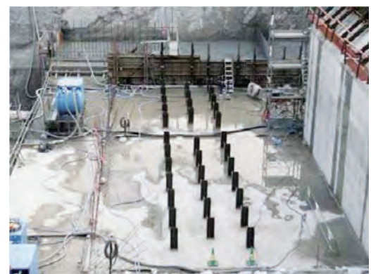
写真二 H型鋼設置完了（躯体の安定対策）
