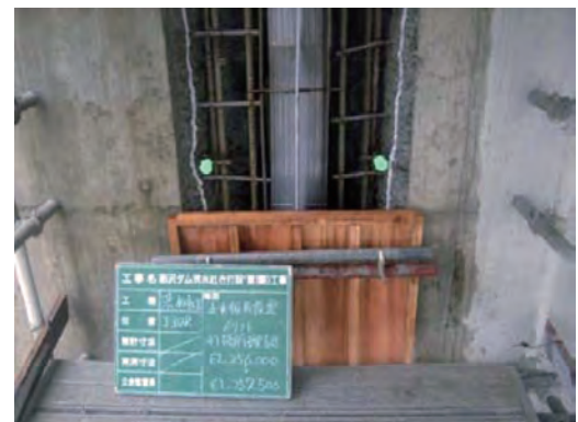
写真一 止水板再設置完了（止水板の損傷対策）
